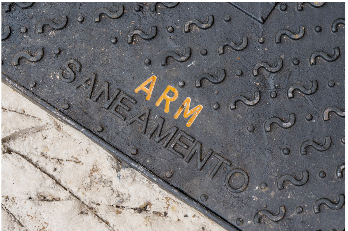
Obra de Saneamento no Garachico
