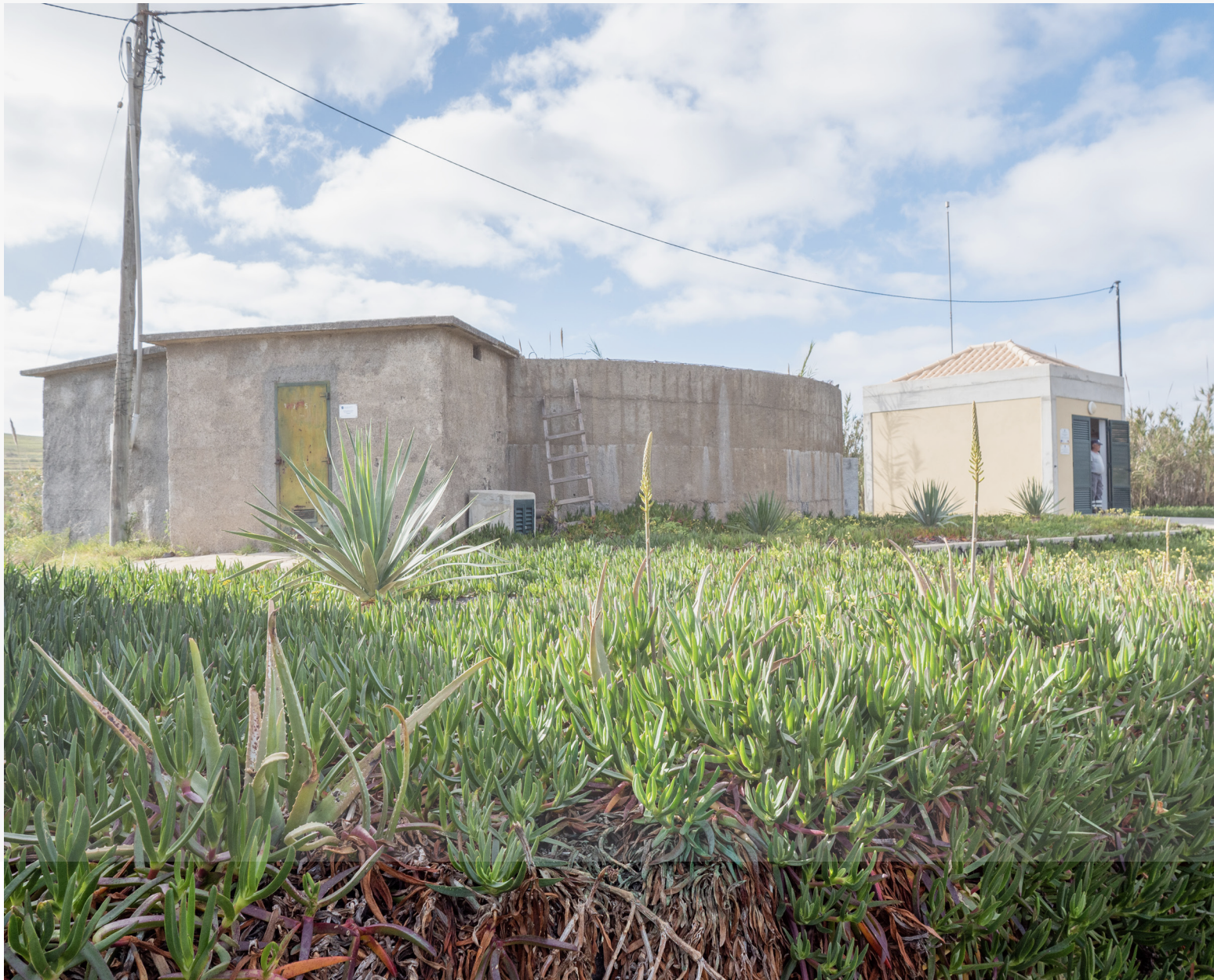
Reservatório de Rega Porto Santo
