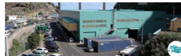
ETZL/ET - ESTAÇÃO DE TRANSFERÊNCIA DA ZONA LESTE E DE TRIAGEM DA MADEIRA, PORTO NOVO
