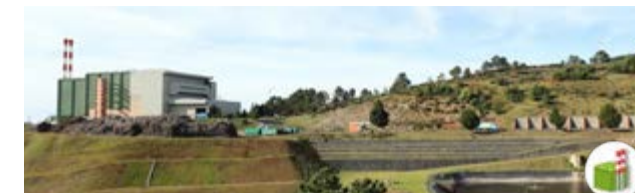
ETRS - ESTAÇÃO DE TRATAMENTO DE RESÍDUOS SÓLIDOS, MEIA SERRA
