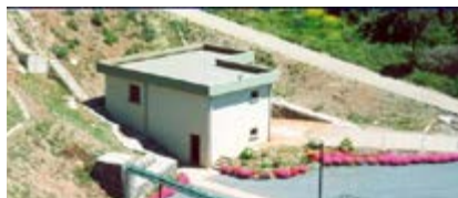
Tratamento Físico-Químico (20m³/h)
