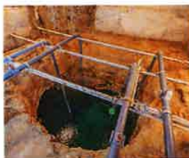
4 Galerias de captação de água salgada
