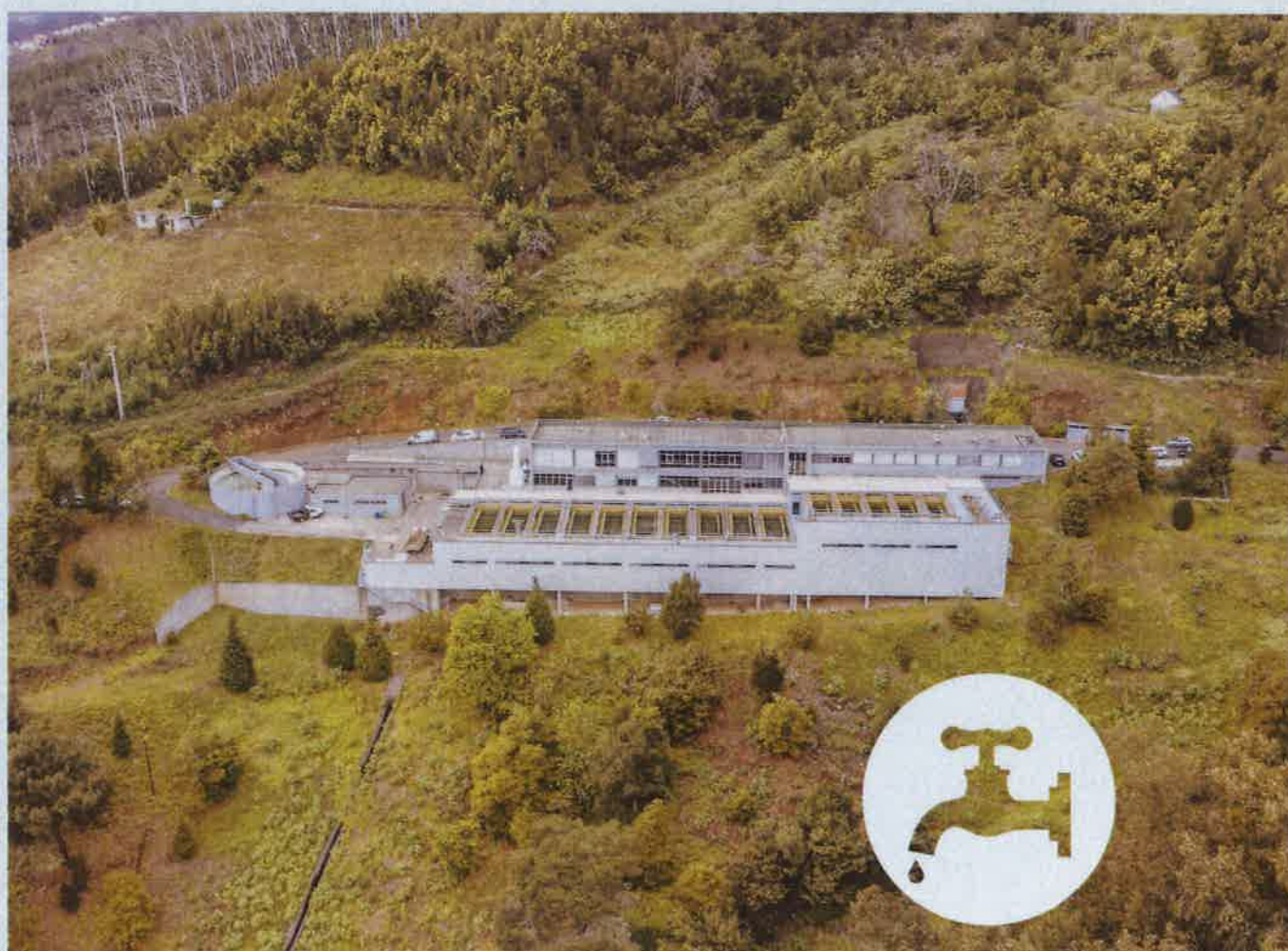
Estação de Tratamento de Água Eng.º Manuel Rafael Amaro da Costa (Alegria)
