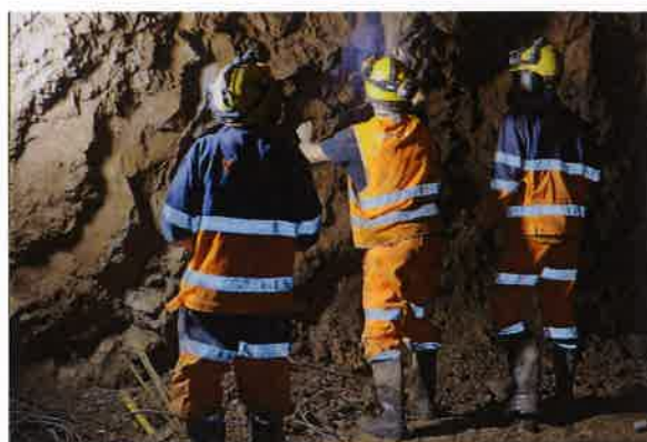
Túnel do Pedregal
