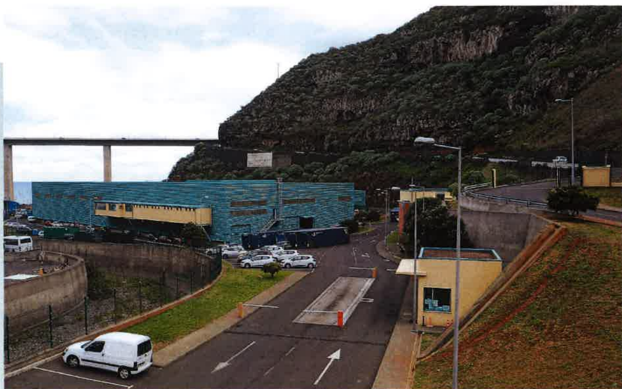
Estação de Transferência da Zona Leste
