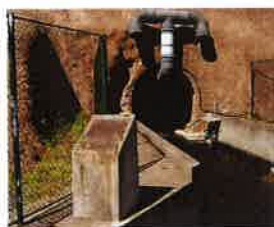
8 Galerias de captação de água doce
