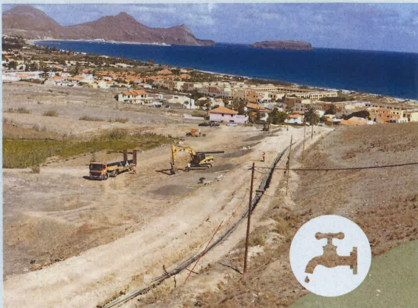
Lançamento de nova conduta, desde o reservatório da Ponta, Porto Santo
