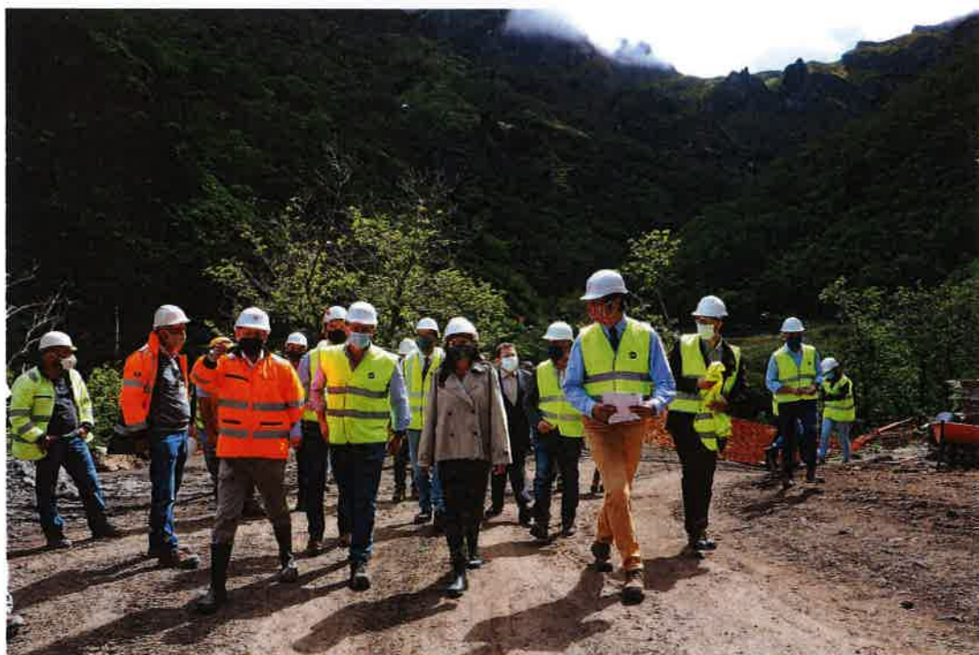
Obra do Túnel do Pedregal
