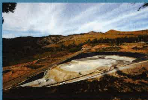
Aterro em operação, ETRS da Meia Serra
