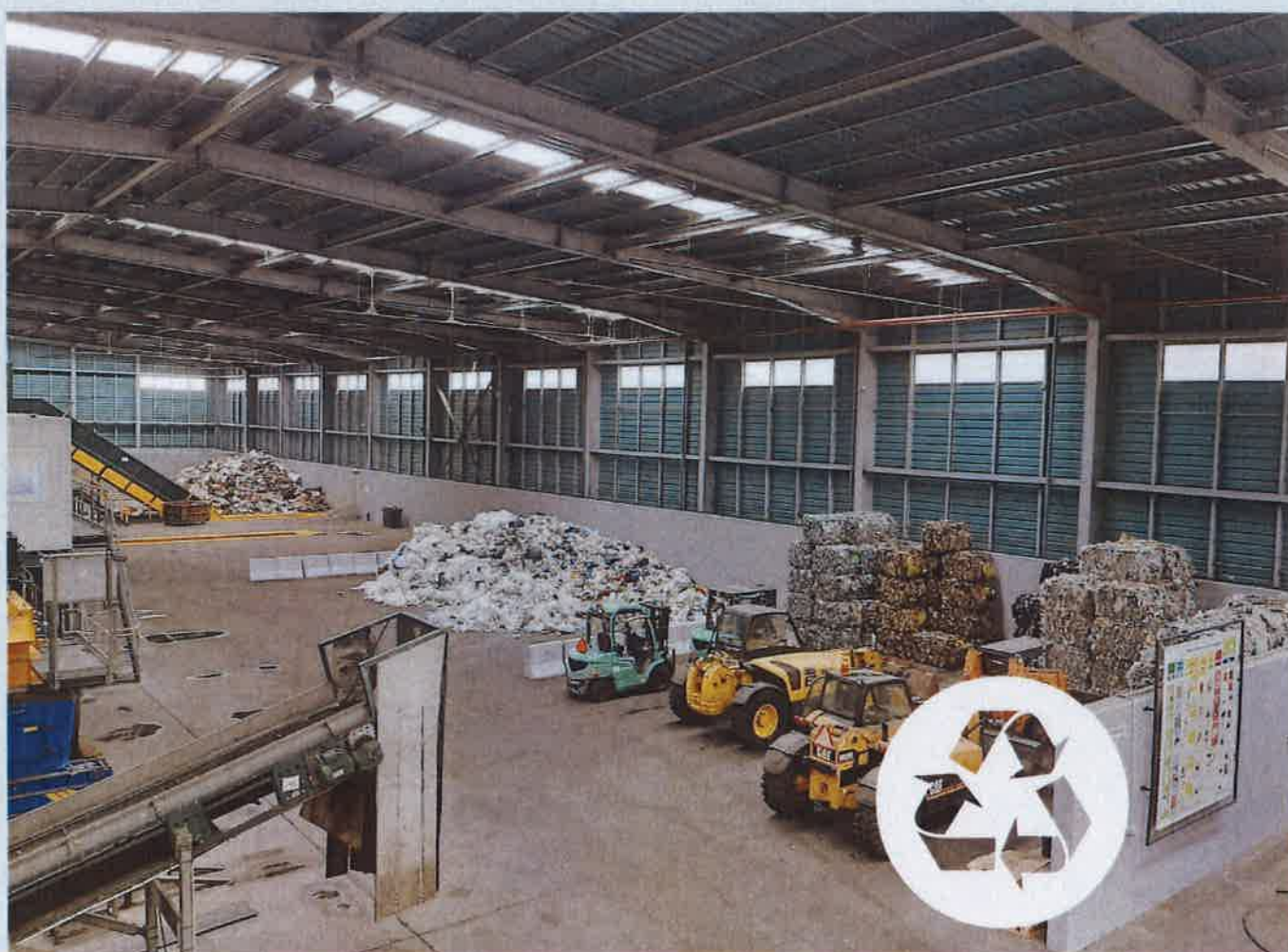
Edifício de Triagem da Estação de Transferência da Zona Leste e Estação de Triagem
