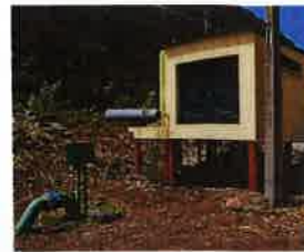
21 Furos de captação de água
