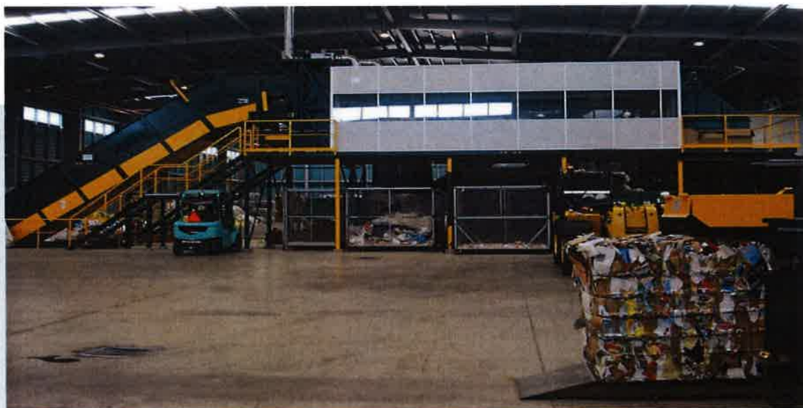
Edifício de Triagem da ETZL/ET
