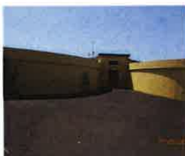
60 Reservatórios de armazenagem
